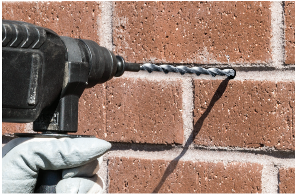
Heli-Tie Helical Wall Tie
