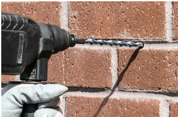
Heli-Tie Helical Wall Tie
